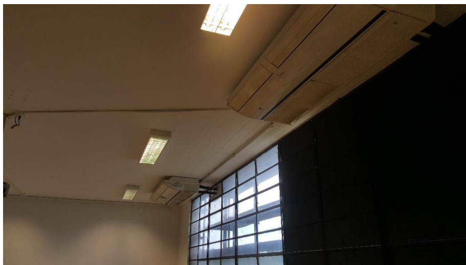
Figura 28 Sistema de condicionamento de ar – unidades evaporadoras Fonte: autoria própria
