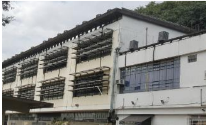
Figura 29 Sistema de condicionamento de ar – unidades condensadores
