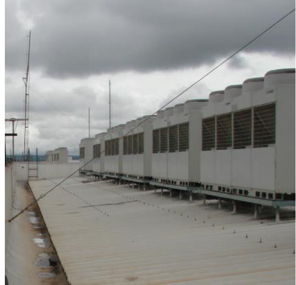
Figura 9 Sistema VRF – Edifício Ministério de Minas e Energia (Fonte: MMA, 2015)
